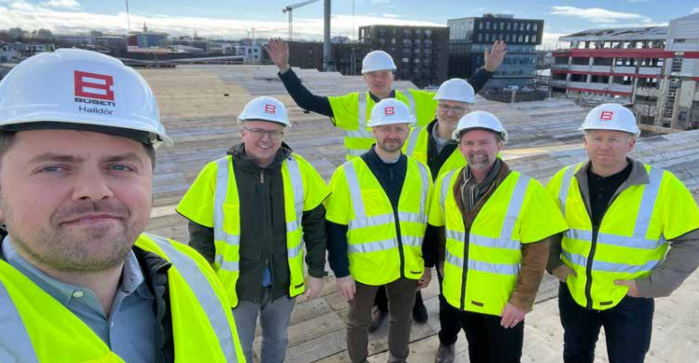
Byggingasvið Búseta við vettvangsskoðun að Hallgerðargötu 24 og 26
